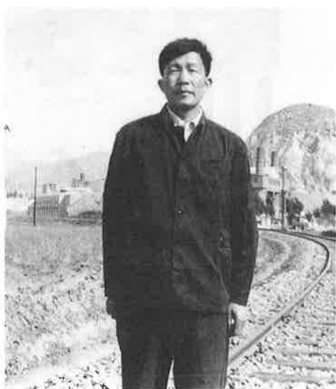
蓟县采石场，铁轨通往石灰、石料装卸场。背景为已开了一半的小渔山和石灰窑。
